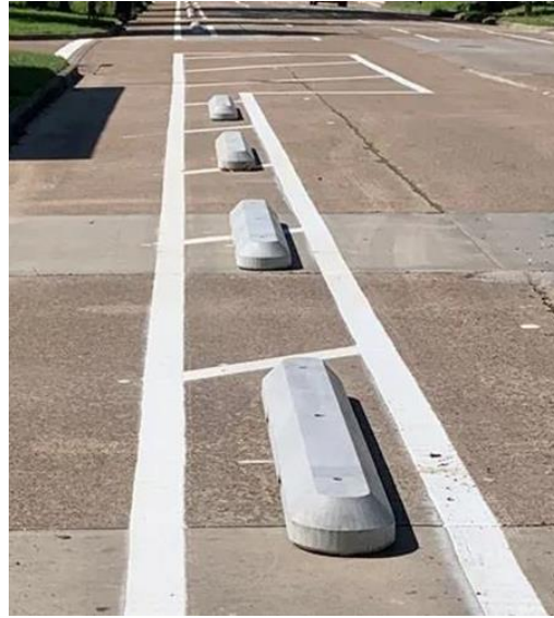
Photo: Concrete curbs Foto: Bordillos de concreto
